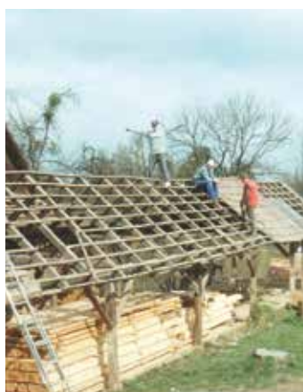
Abtragen und Neuerrichten der Loambudl im Frühjahr 1997 beim vulgo Neuwirt
