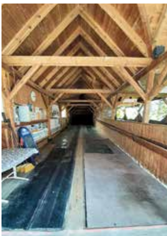
Fertiggestellte Loambudel mit Überdachung beim vulgo Neuwirt in den Sommermonaten des Jahres 1997.
