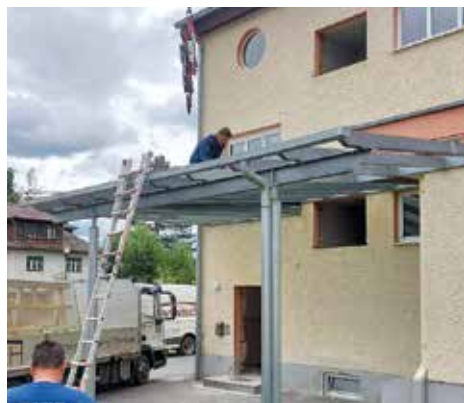
Viel Brauchbares wie Fenster, Türen, etc. konnte im Vorfeld von der Bevölkerung ausgebaut werden.
